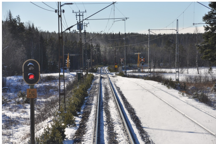
Figur 1. Normalhuvudspår och avvikande huvudspår i Fångsjöbacken. I förgrunden syns mellansignal 2/5 och i bakgrunden den huvudspårsskiljande växeln. Fotot är taget i samband med haverikommissionens medåkning i februari 2017.
