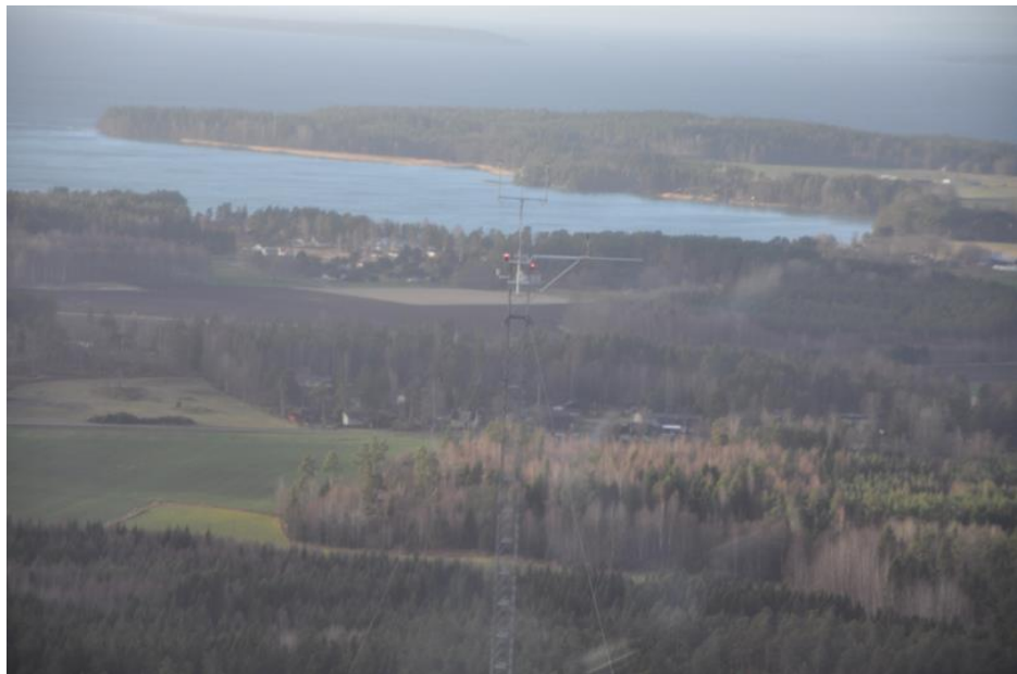
Figur 7. Masten fotograferad från en flyghöjd väl över mastens högsta punkt. De fasta röda ljusen är då synliga.
