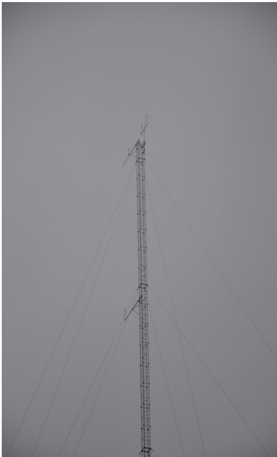
Figur 5. Den aktuella mastens övre del fotograferad från marken. Det finns inga synliga hinderljus eller annan utmärkning.
