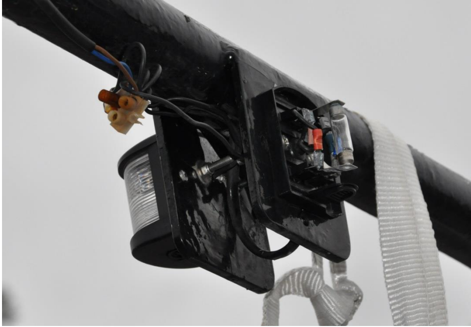
Fig 10. För- och akterlanterna monterade på bågen. Notera kabelskrivningen till vänster i bild.
