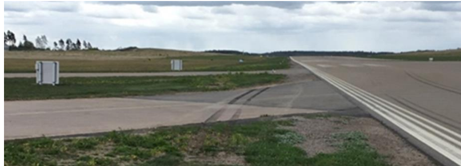
Figur 11. Bilden visar vänster hjulspår i banriktningen. Till vänster syns två av metallskyltarna. Publiceringstillstånd från Saab AB.
