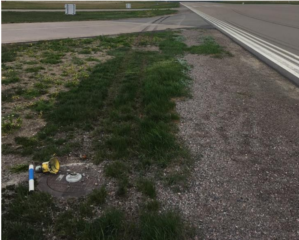
Figur 4. Däckspår till vänster om bankanten i startriktningen på bana 11 samt skador på banljus. Foto: Saab AB.
