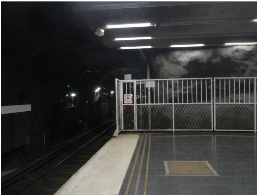
Figur 7. Stängsel med låst grind vid norra kortsidan av plattformen i Masmo.
