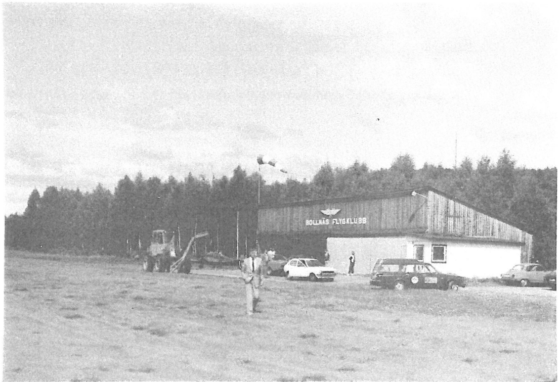
Fig 3. Hangar med vindstrut
