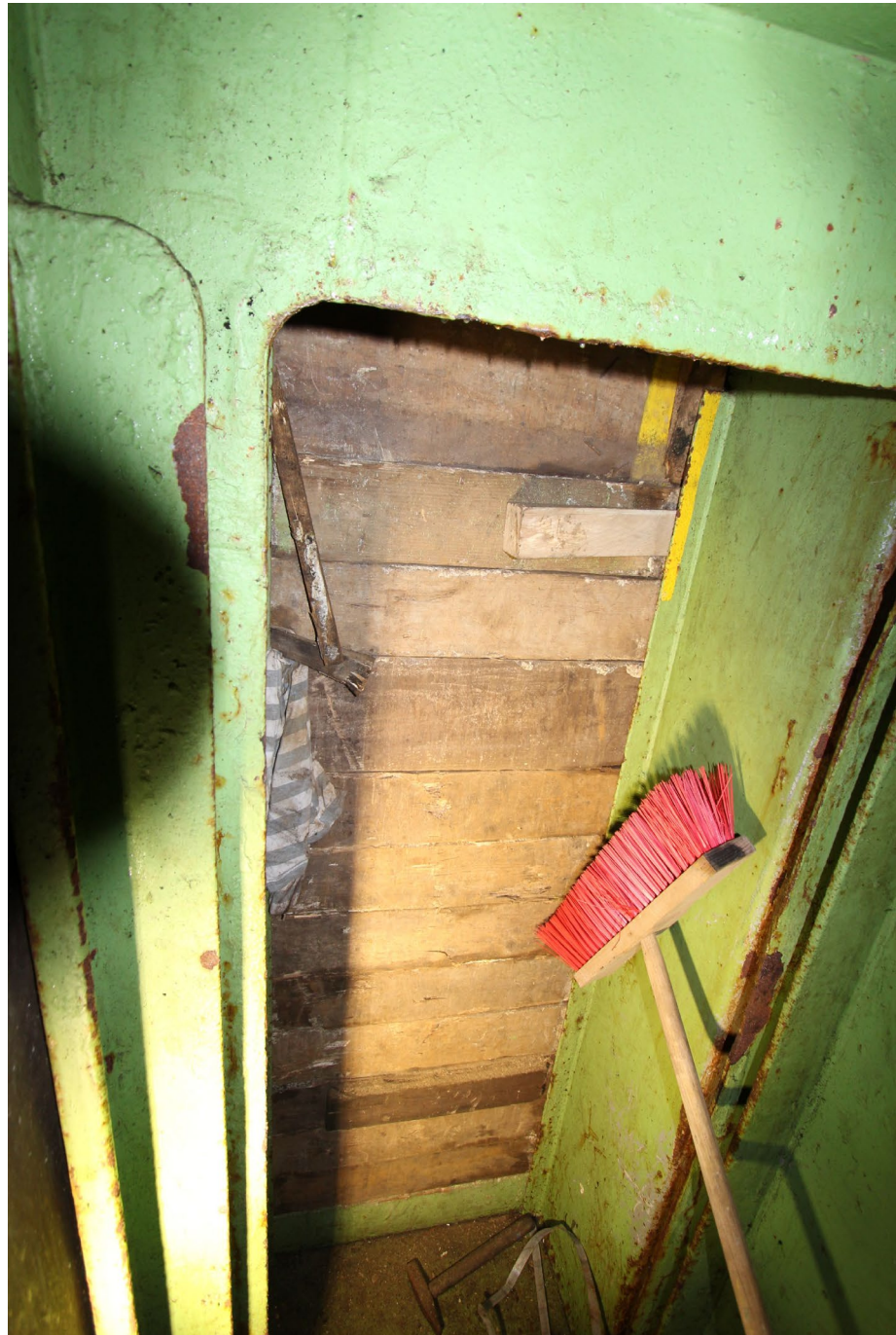
Fig 4. Den temporärt uppbyggda väggen i dörrhålet från lastrumsnedgången in till lastrummet. Bilden är tagen i botten på nedgången och visar insidan av dörrhålet som syns i fig 3. Bild: Polismyndigheten.
