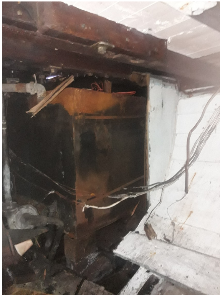
Figur 16. Vy från lastrummet mot motorrummet. Mitt i bilden är babords bränsletank och delar av skottet mellan utrymmena syns till höger om tanken.
