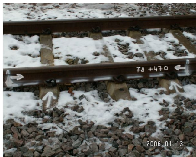
Figur 33. Utdrag från Infranord Mätenhetens arbetsinstruktion Manuell OFP av räler och rälskomponenter i spår . Exempelbild på hur fel med stor utbredning ska markeras i anläggningen. Källa: Infranord Mätenheten
