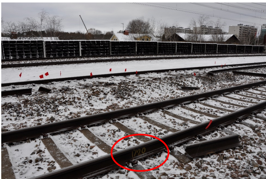
Figur 8. Intilliggande räl märkt med 720 i gul färg. Motsvarande märkning fanns även på en av delarna från rälsbrottet (se figur 16).
