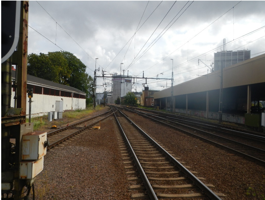
Figur 2. Bild från plattformen mot växel 417a tagen av SHK vid platsbesöket den 22 augusti.
