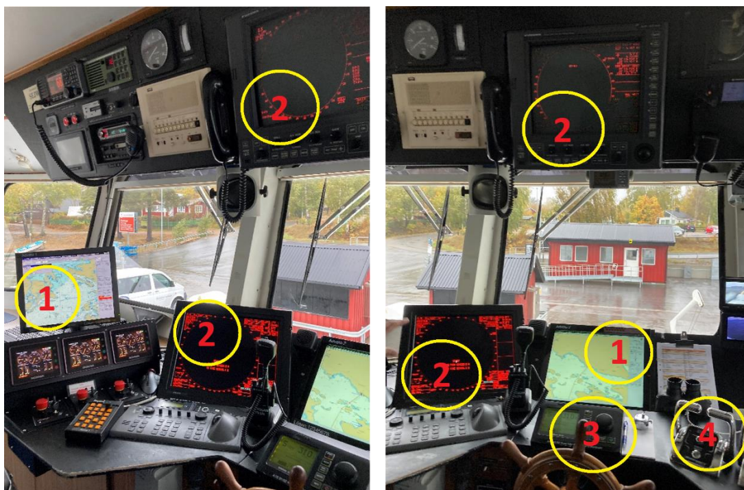
Figur 17. Befälhavarens plats i styrhytten ombord på SILVERPILEN. Elektroniska sjökort markerade med 1, radarskärmar med 2, automatstyrning med 3, samtas- och växelreglage med 4.
