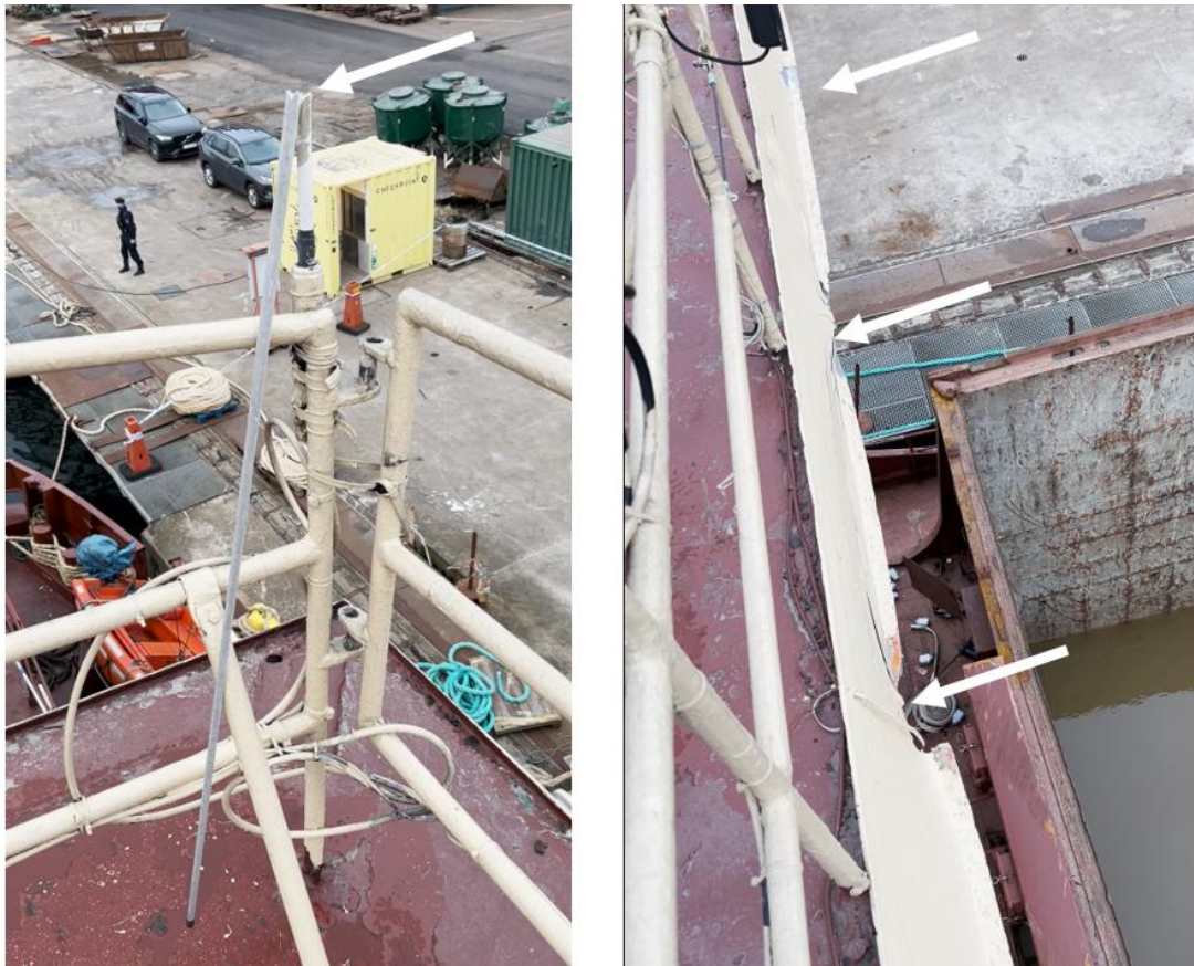
Figur 10. Brygghestaket. Vänstra bilden: I babords aktra hörn var en antenn knäckt. Högra bilden: Plåtskärmen ovanför bryggans fönster hade skadats av lastrumslucka 5.
