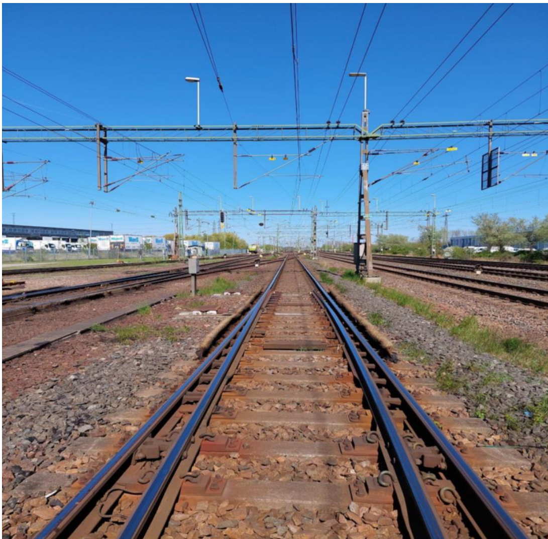
Figur 7. Fotot som är taget den 27 april visar siktförhållandena i växel 717 och spår 61 mot det håll som tåget kom ifrån (Lund). Till höger syns spår 6264 där den största tillåtna hastigheten också är 160 km/tim. Till vänster syns spår med lägre hastighet. På platsen finns ett dike mellan spår 61 och 62. Foto: Olycksplatsansvarig från Infranord AB på uppdrag av Trafikverket.
