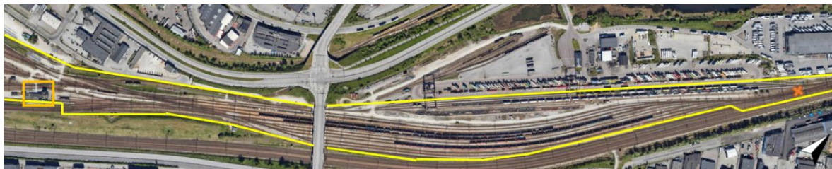
Figur 1. Malmö godsbangård. Gul markering är tillförd av SHK och visar området inom vilket de flesta besiktningsanmärkningarna fanns. Orange ruta visar rangertornet från vilket rangering av vagnar styrs. Orange kryss visar olycksplatsen. Bild: Google Maps.
