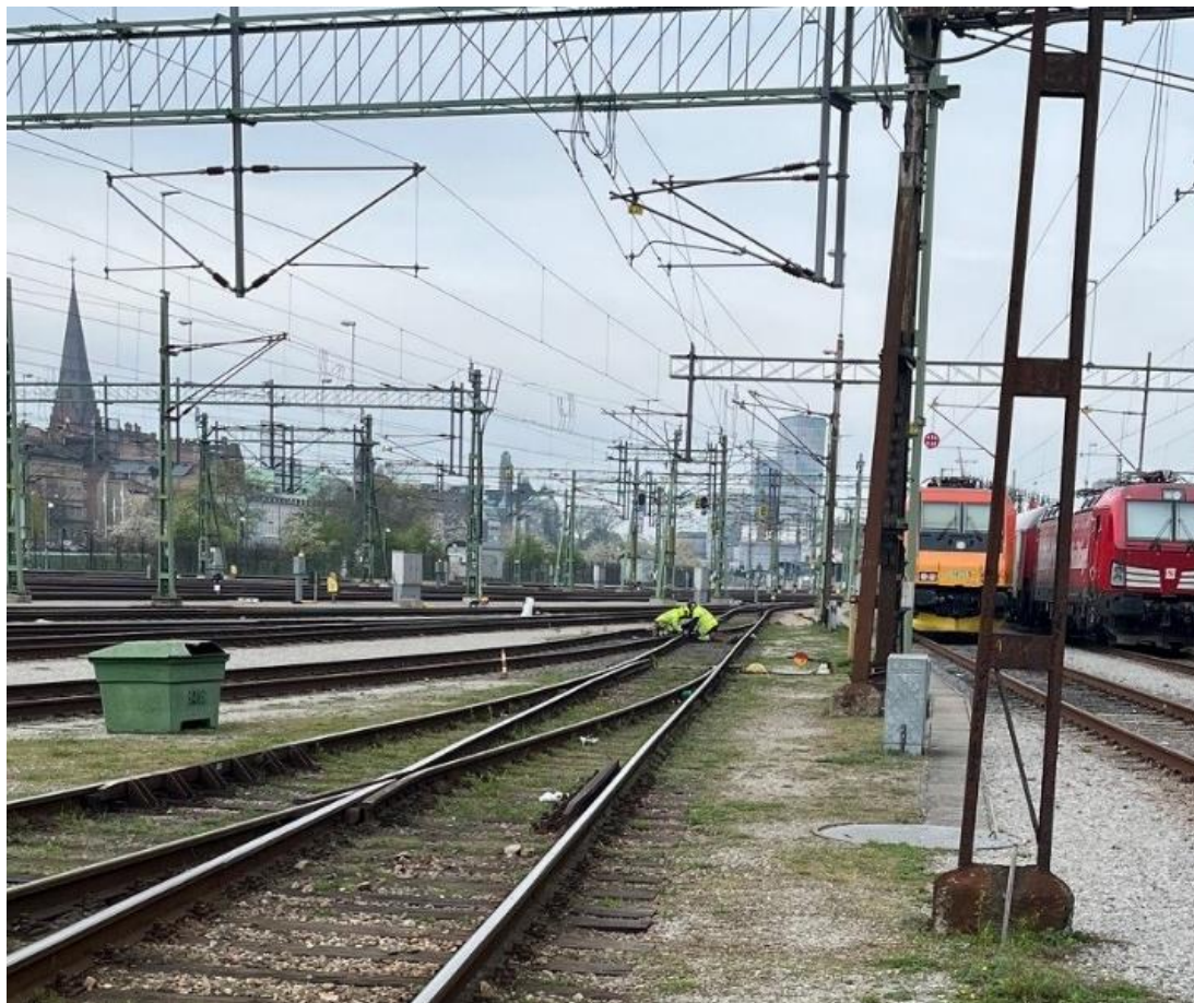
Figur 10. Arbetslaget arbetar i växel 383. Arbetsplatskontrollanten tog bilden innan han gick fram till arbetslaget. Källa: Trafikverket.
