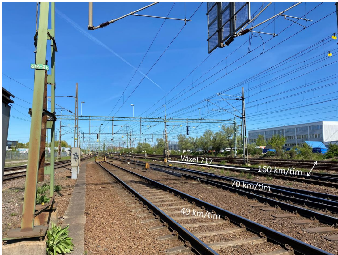
Figur 6. Spårområdet runt växel 717. Fotografens placering är vid teknikhusen. Strax bakom fotografen stod arbetslagets parkerade bil. Fotot är taget den 29 april.
