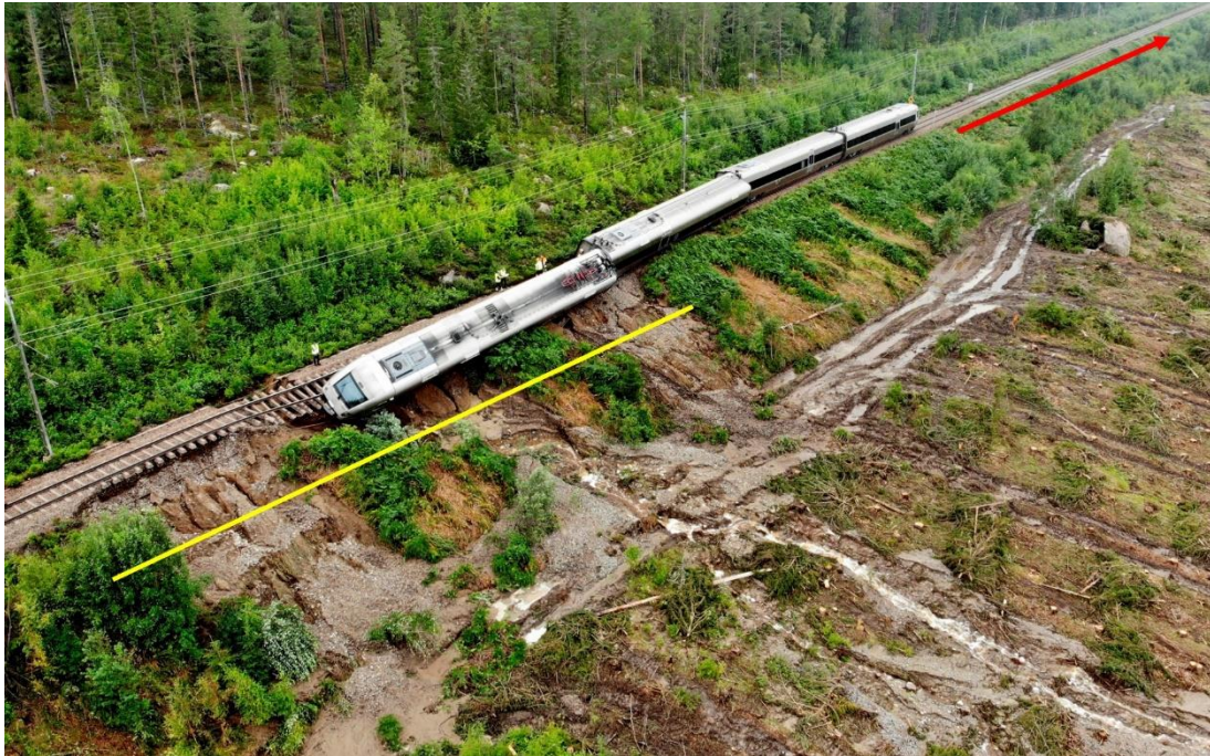
Bilden visar olycksområdet. Vatten har runnit genom banvallen och fört med sig material från banvallen till nedströms liggande mark. Markeringar inlagda av SHK. Den gula markeringen visar rasområdet och den röda pilen visar tågets färdriktning. Foto: Mats Andersson.
