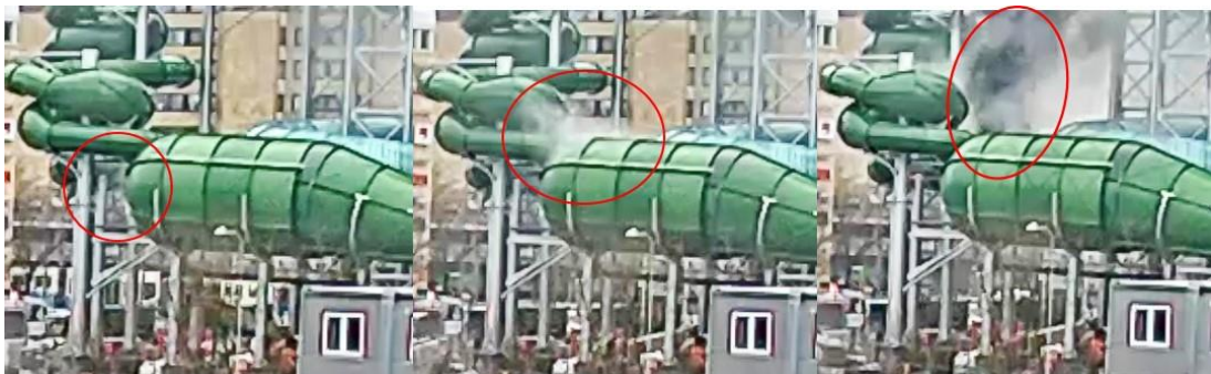
Figur 4. Bildserie från övervakningsfilm. Kl. 10.03 syns ljus rök komma från vattenrutschkanan Rattler. Kl. 10.04 har röken ökat i intensitet och kl. 10.05 har den mörknat. Källa: Liseberg. De röda cirklarna som markerar röken har tillförts av SHK.
