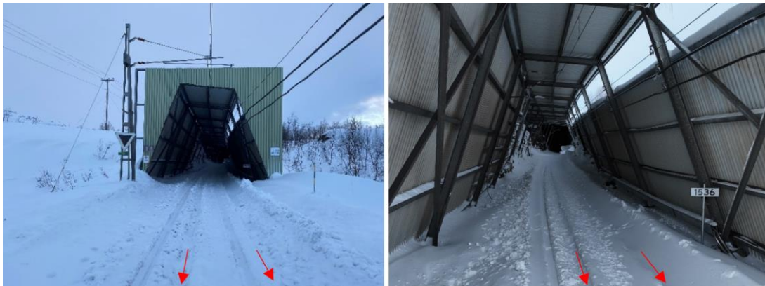
Figur 16 visar snögalleri 14 före maskinell snöröjning. Till vänster in genom öppningen från Vassijaure och till höger cirka 30 meter längre in där drivbildningen började att täcka spåret. Märken efter urspårade hjulaxlar är markerade med röda pilar.
