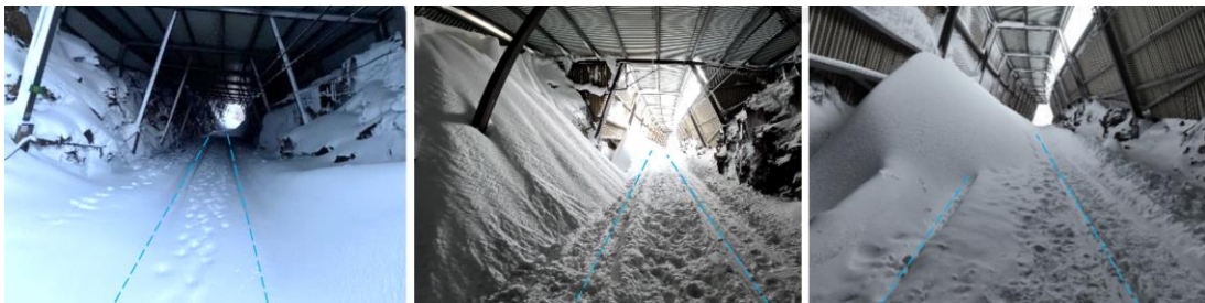
Figur 19 visar till vänster spåret in mot mittensektionen av snögalleri 14 och bergsskärningen. Där var det mindre snö och inga märken efter urspårade hjulaxlar. I mitten visas snögalleriet i bergsskärningen och vidare mot den västra delen. Till höger visas den västra änden av snögalleriet med en kraftig snödriva. Spåret och rälernas placering är illustrerade av SHK med blå streckade linjer.
