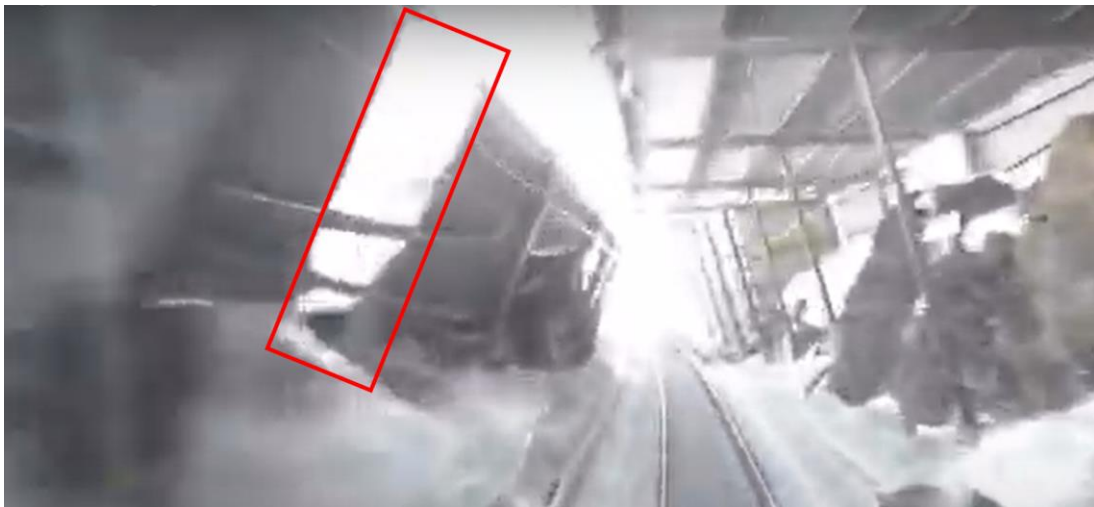
Figur 25 visar ett skärmsklipp från en videofilm genom snögalleri 14 i april 2018. Foto: Martin Långström.
