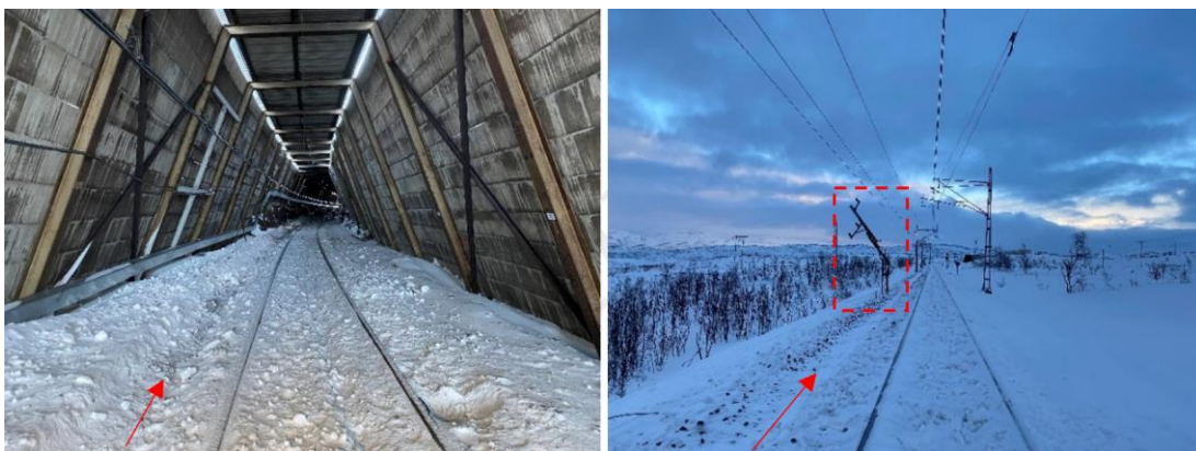
Figur 15 till vänster visar med röd pil märken av urspårade hjulaxlar genom snögalleri 13A. Till höger visas motsvarande märken av hjulaxlar på raksträckan bakåt mellan snögalleri 13A och 14. På bilden ses även den skadade kontaktledningsstolpen i röd ram.
