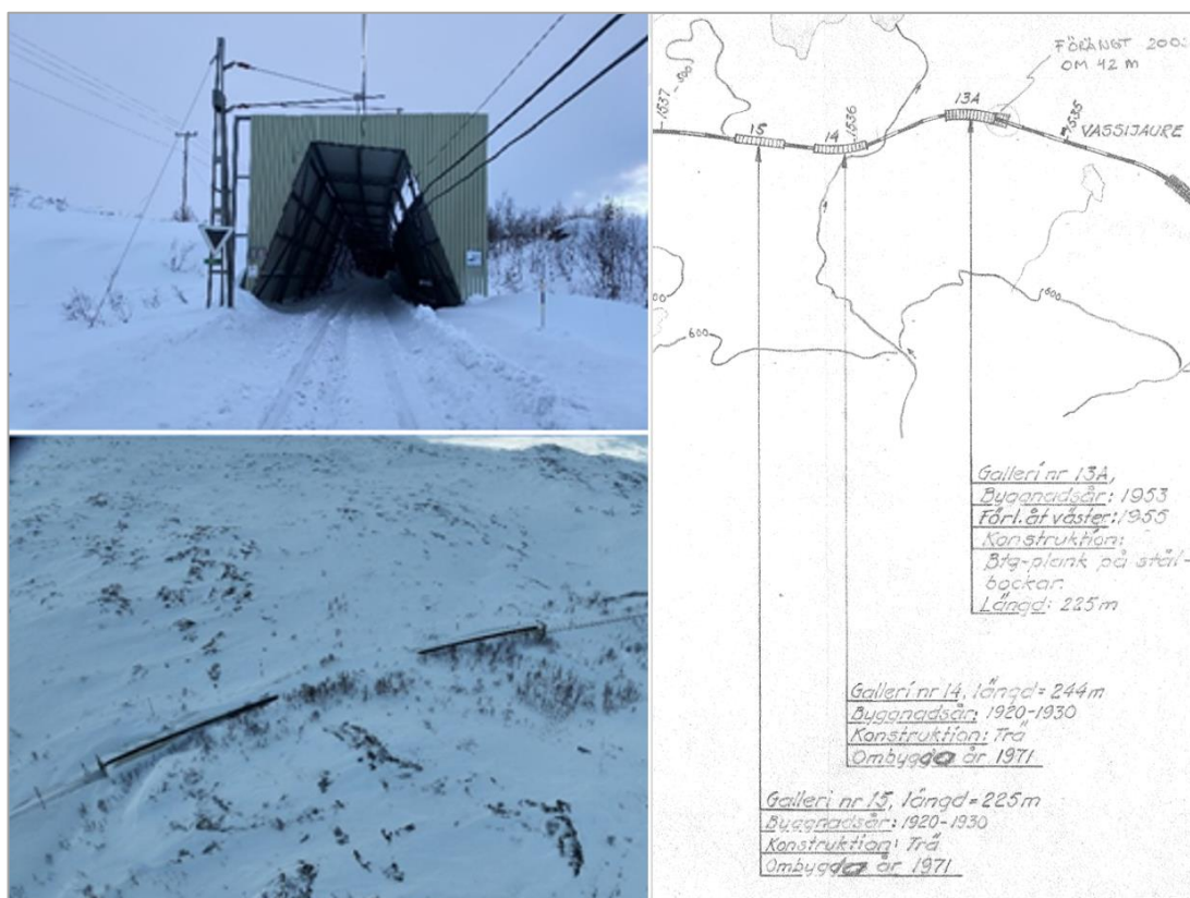
Figur 4 visar uppe till vänster den östra gaveln på snögalleri 14, som tåget körde ut igenom. Nere till vänster visas en drönbild över snögalleriet norrifrån med Vassijaure åt vänster i bild. Till höger visas en delförstoring av ritningen från Statens Järnvägar med data om snögallerierna. Källa ritning: Trafikverket.
