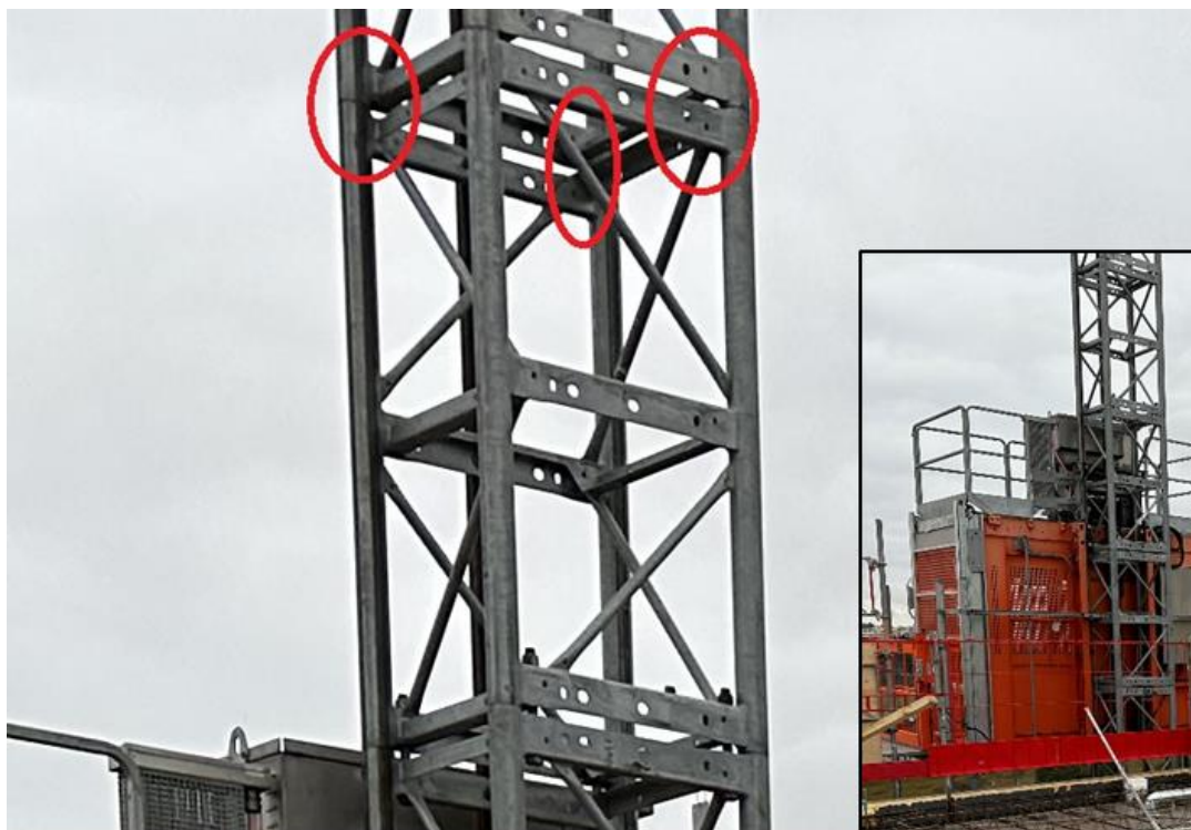
Figur 18. Fotografi från den 9 november. På bilden syns att det inte finns skruvförband mellan mastsektionerna. Platsen för skruvhålen är markerade med röda cirklar. Bilden är beskuren och inzoomad av SHK. Notera att skruvförband syns i mastsektionsskarven längs ned i bilden. Bild: Andersson Company Byggnads AB. Markeringar infogade av SHK.
