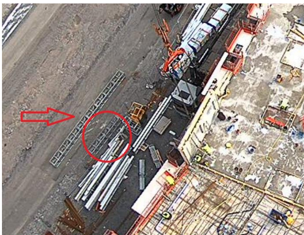
Figur 12. På bilden syns åtta sammanfogade mastsektioner på marken som har förberetts inför lyft med tornkran, markering med röd pil. På marken ligger också tre sammanfogade mastsektioner, röd markering med cirkel. Bild: Andersson Company Byggnads AB
