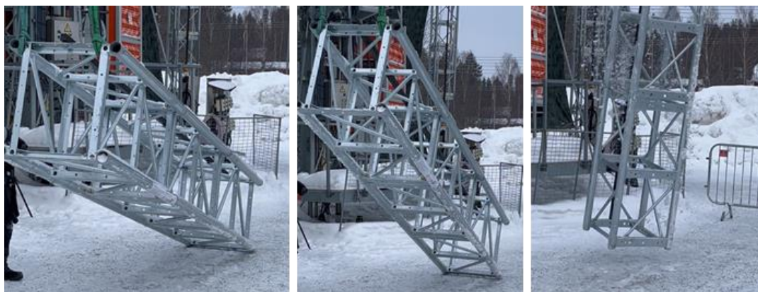
Figur 21. Lyft av en mast monterad av tre mastsektioner där det saknas skruvförband mellan den mellersta och den nedersta mastsektionen.
