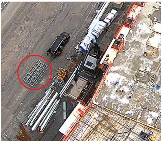
Figur 11. Bild från den 17 augusti. På bilden ses transportbilen lasta av hissdelar, mastsektionerna är markerade med röd cirkel. Bild: Andersson Company Byggnads AB. Markering av SHK.
