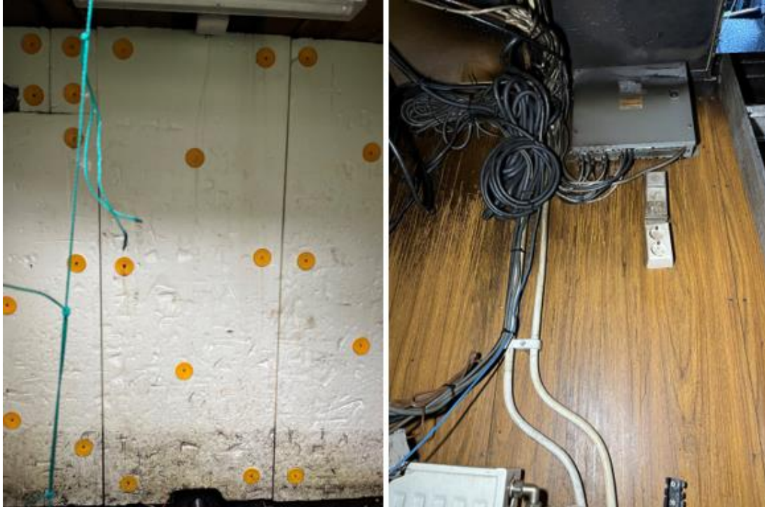
Figur 9. Vänstra bilden visar maskinrummets aktra skott sett från lastrummets sida. Högra bilden visar maskinrummets förliga skott sett inifrån skansen för om maskinrummet.
