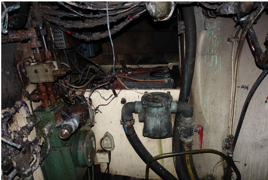
Foto 5. Förbrukningsbatterierna är oskadade
