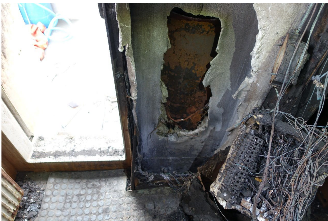
Foto 2. Luftschaktet, samt schakt för avgasröret.
